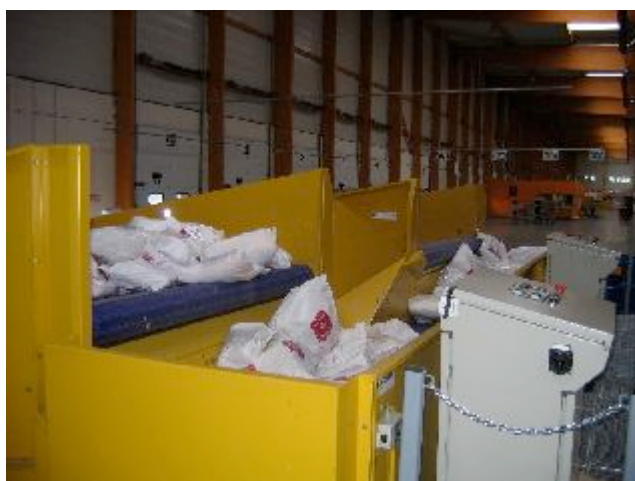
Figura 35 – Esteira de entrada do centro de triagem
